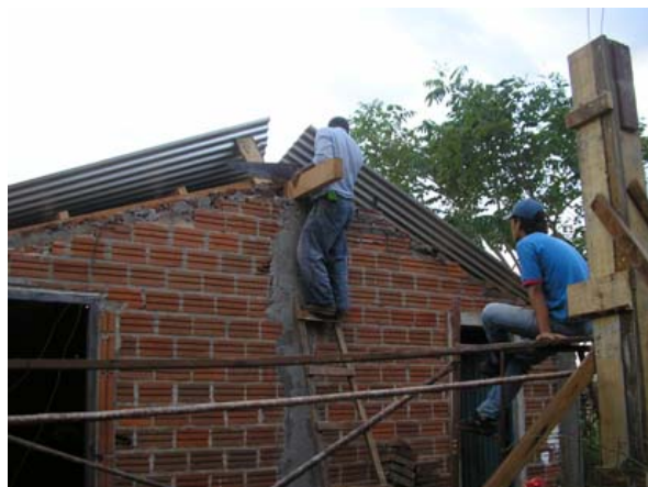
Het nieuwe dak
